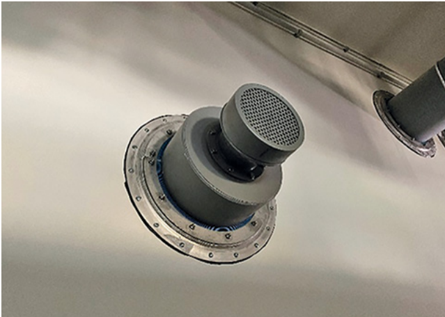
Abbildung: Fertige Überströmung ITR
