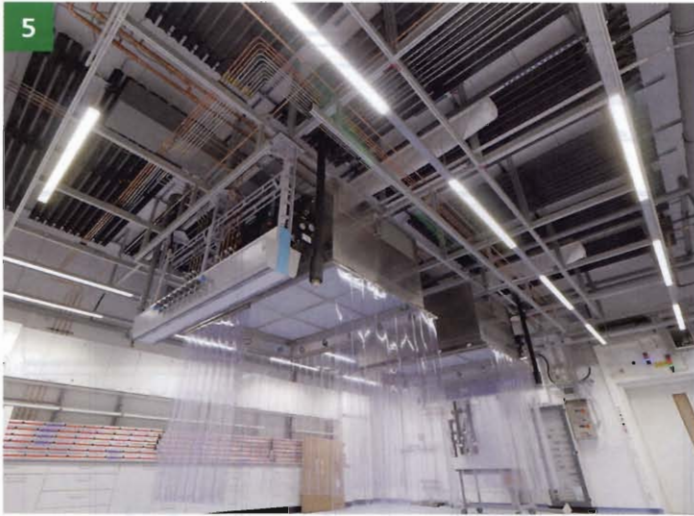
Mikroskopiellabor mit Reinraumbereichen und Medienversorgung über die Decke
