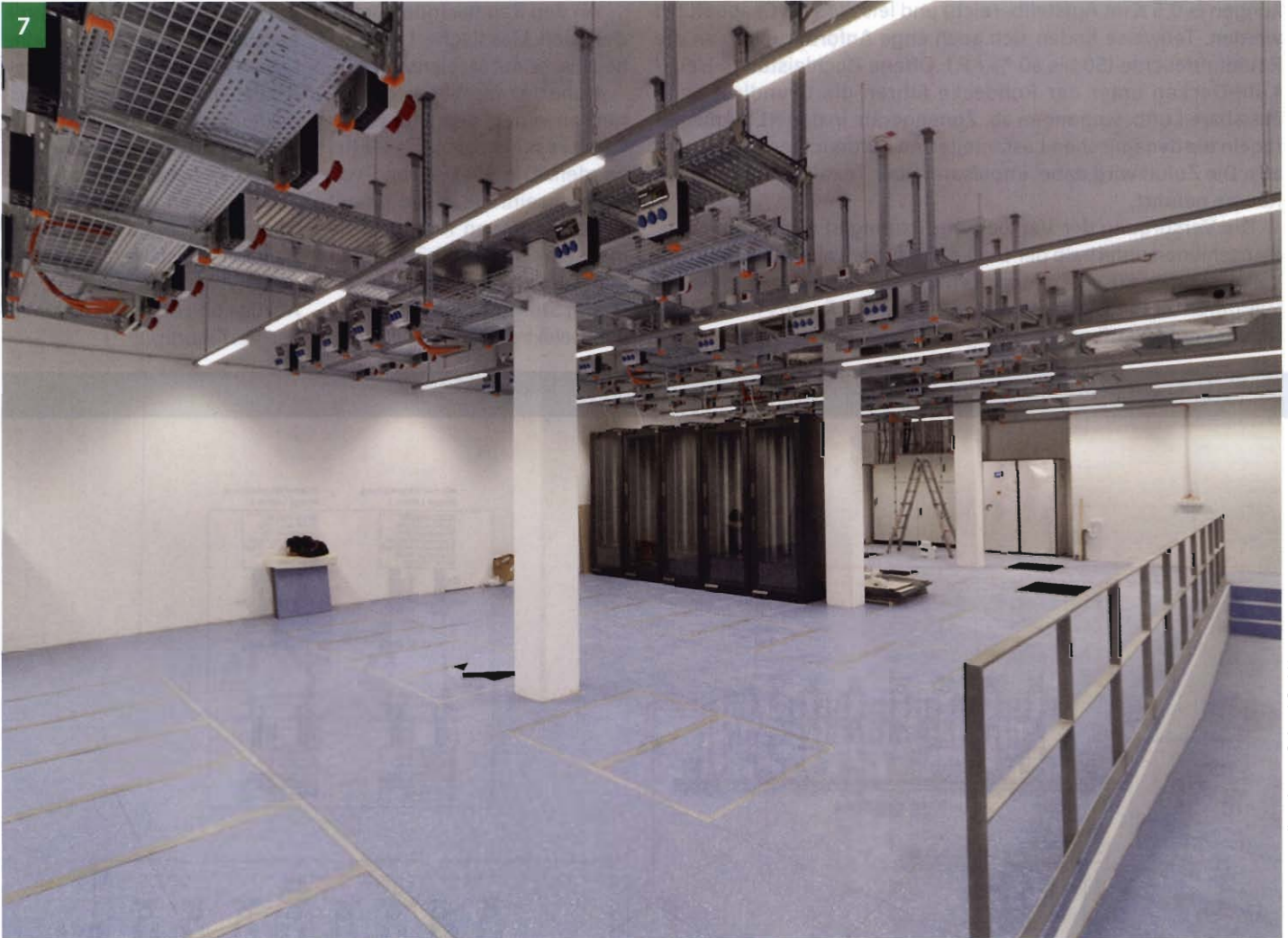
Rechenzentrum mit Versorgung aus dem Doppelboden (Kühlwasser, Luft) und der Decke (Strom, Daten)
